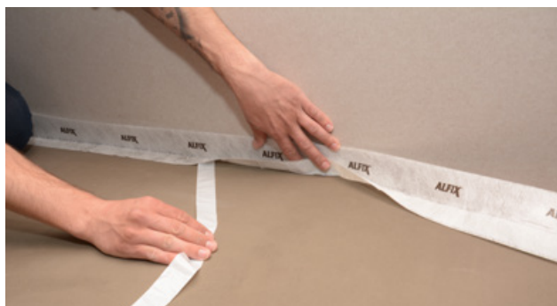
Montering af selvklæbende vægkantbånd
