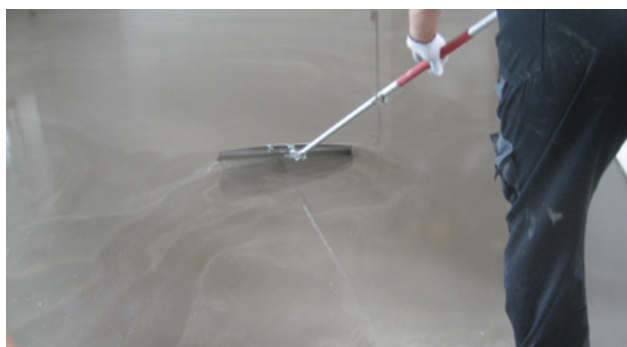
Fordeling af spartelmassen
