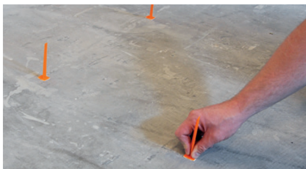
Markering med kotemål
