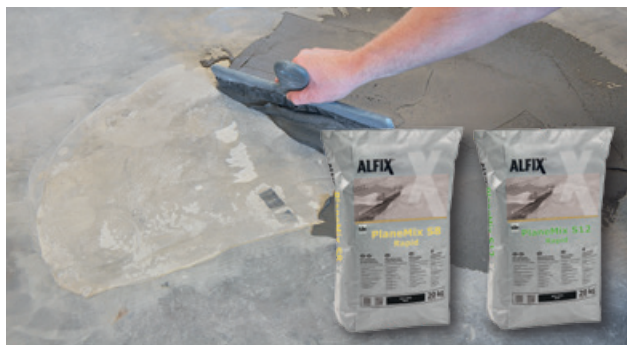
Revner og lunger udbedres
