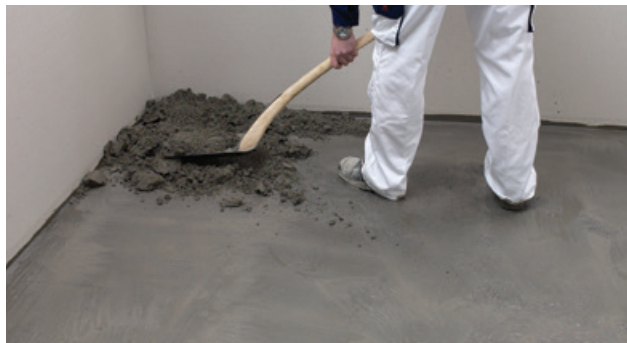
Støbemasse fordeles jævnt
