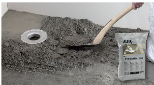
Opbygning af fald med støbemasse
