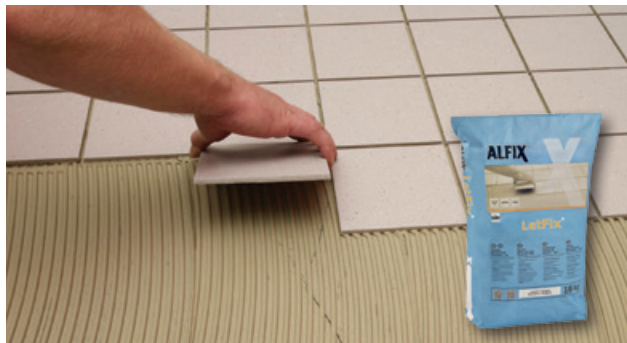
Flisemontering i Alfix fliseklæber
