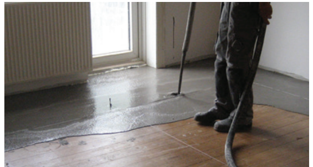
Spartling på træbjælkelag
