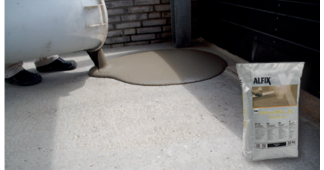
Udhældning af selvudflydende spartelmasse
