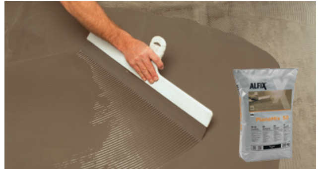
Fordeling af spartelmasse
