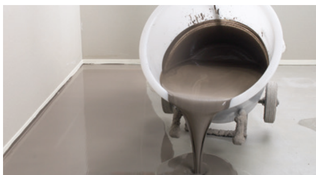
Udhældning af spartelmasse
