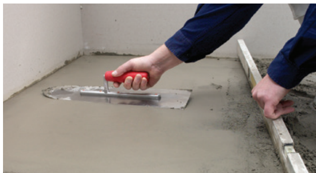
Støbemasse glattes ud med spartel
