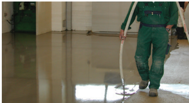
Udlægning med spartelpumpe
