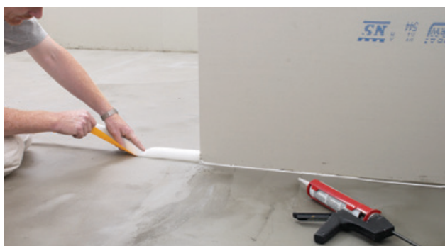
Afgrænsning med selvklæbende spartelstop
