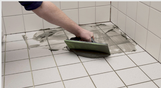
Påföring av fogmassa
