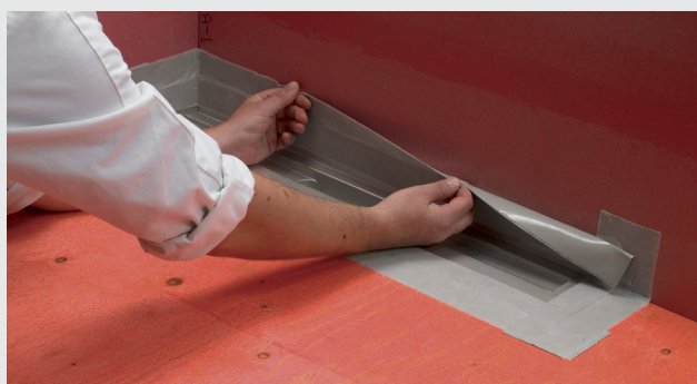
Montering av Seal-Strip vid väggnära golvbrunn
