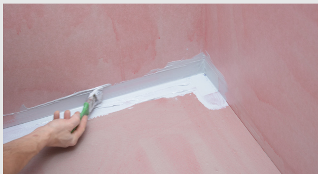
Montering av Armeringsremsa i tätningsmassa
