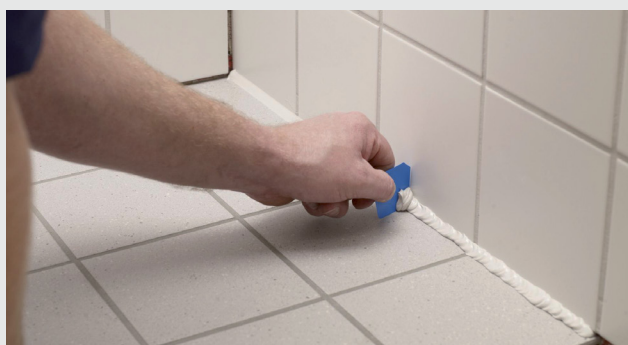
Överskjutande fogmassa skrapas bort
