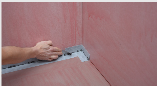
Montering av Seal-Strip, självhäftande
