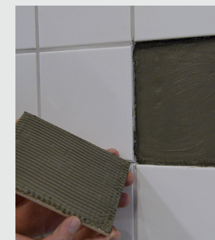
Tätningsmassan påförs underlaget och plattan monteras
