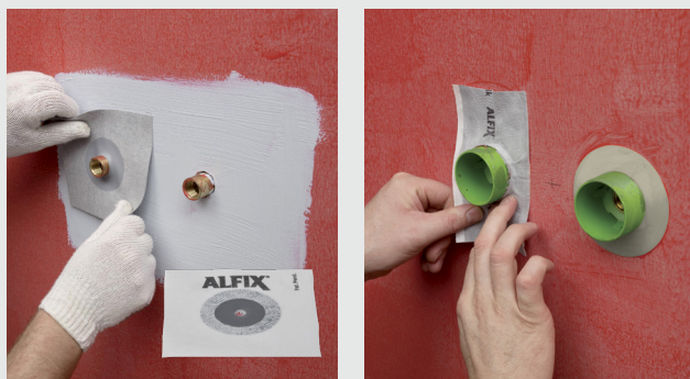
Montering av rörmanschett i 1K eller 2K Tätningsmassa
