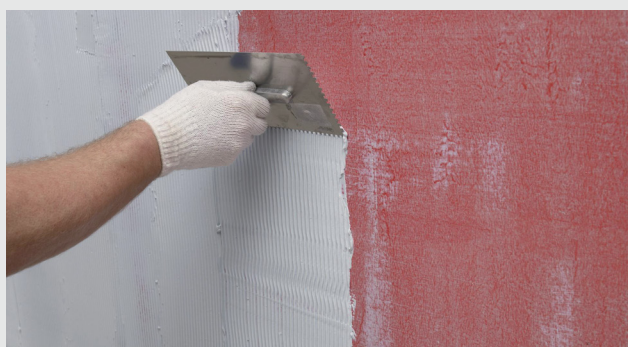
Påföring med tandspackel
