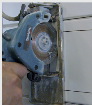
Skär ett spår langs plattkanter. Avlägsna plattan försiktigt
