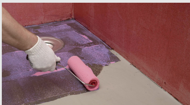
Påföring av Alfix Vattenspärr på massiv golv med roller
