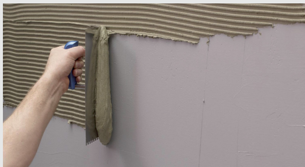
Påföring av fästmassa
