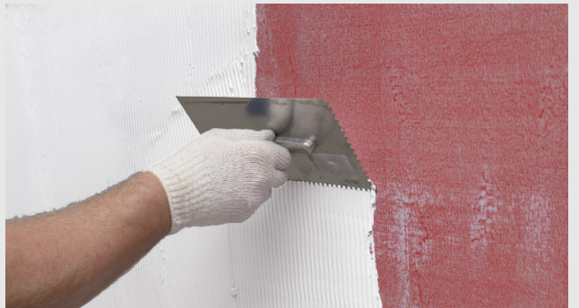
Påföring med tandspackel...
