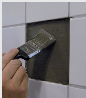
Tätningsmassan påförs underlaget och plattan monteras
