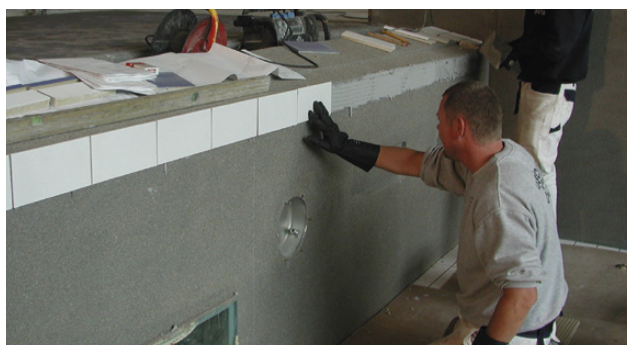
Montering av plattor i den fuktiga fästmassa
