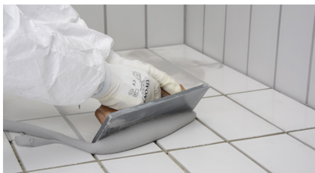
Ifyllning på golv med epoxifogbräda
