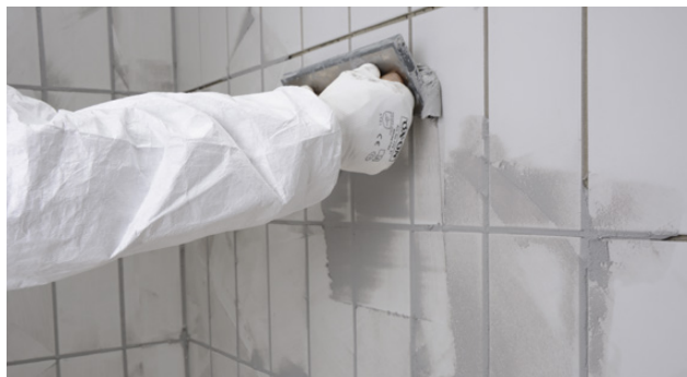
Ifyllning på vägg med epoxifogbräda
