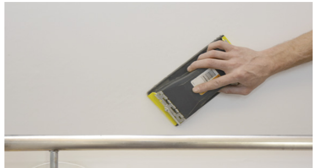
Grovslipning av PVC-liners
