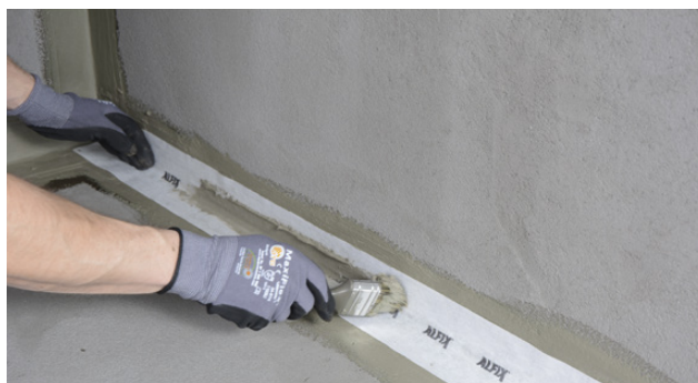
Montering av Alfix VT-tättningsband
