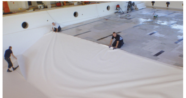
Montering av PVC-liners
