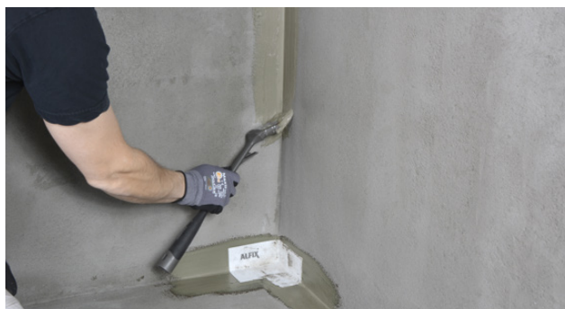
Montering av Alfix VT-hörn i tättningsmassa
