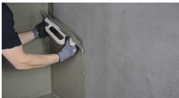
Applicering av Alfix 2K Tätningsmassa – porfyllande skikt
