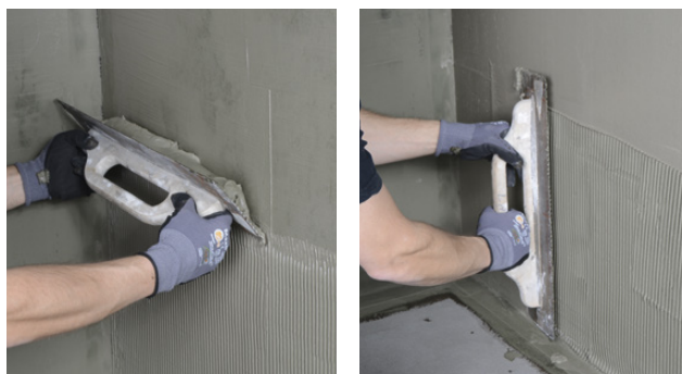
Applicering av Alfix 2K Tätningsmassa och glättning
