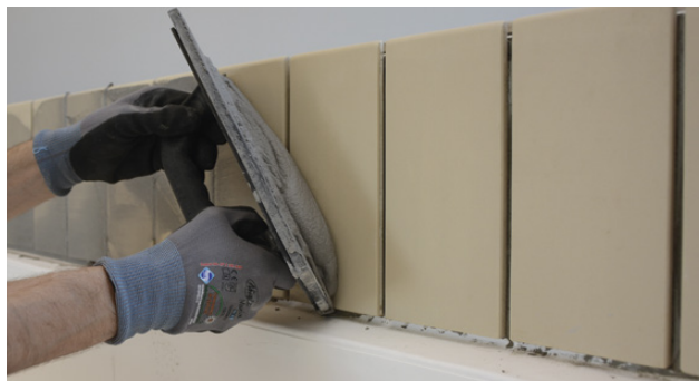
Ifylling av Alfix IndustryFuge - CeraFill 18
