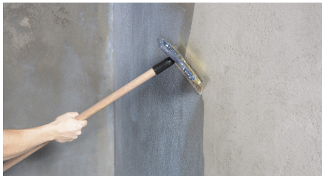
Primerbehandling med Alfix PlaneMixPrime
