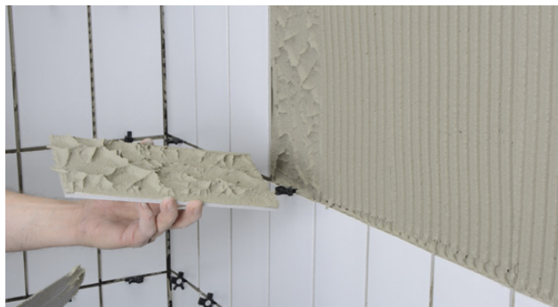
Kontroll av fästmassans täckning
