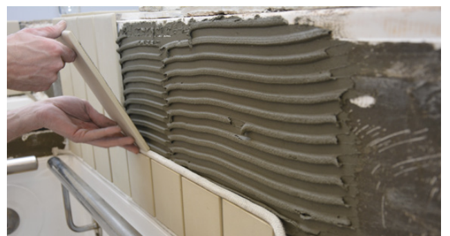
Montering av plattor
