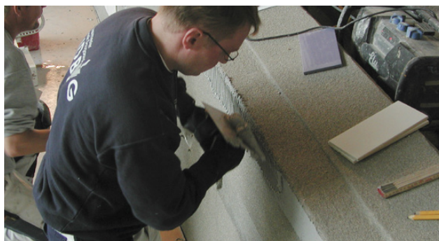
Applicering av Alfix EpoxyFuge 20 med tandspackel
