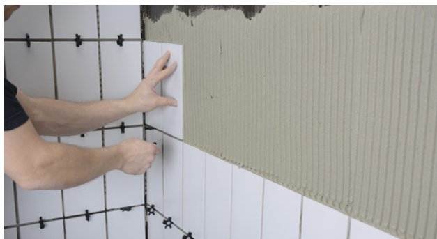
Montering av plattor
