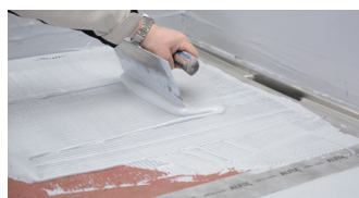
Tätningsmassa påförs och kammats
