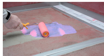
Påföring av Vattenspär
